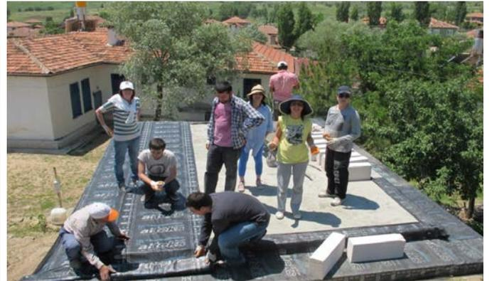
Şekil 2: ODTÜ öğrencileri kerpiç evin ısı performansını artırarak daha verimli çalışabilmesi için çatı yalıtımı yapıyorlar.
